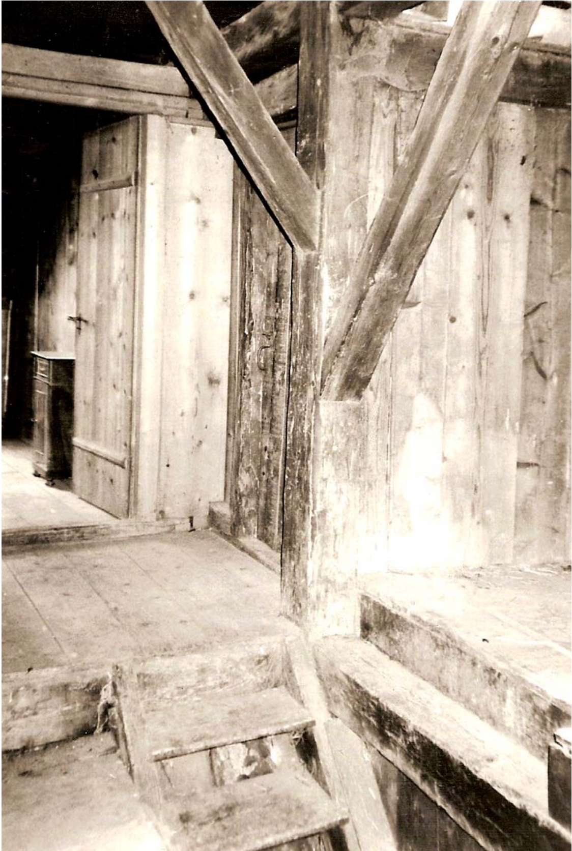
En haut de l'escalier, nous sommes donc maintenant au niveau du galetas, à gauche (non visible) la grande cheminée de ciment (depuis 1930 environ). En face de l'escalier la porte de la chambre neuve (de 1842), et à droite la porte de la chambre primitive.
